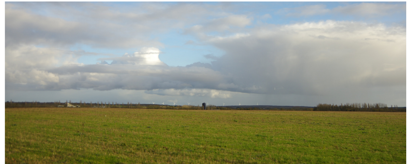
Parc éolien Salles de Villefagnan depuis la D740 - Organisation en ligne
