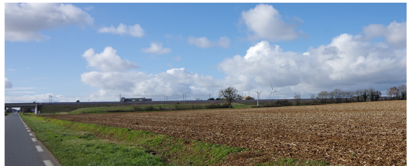
Ligne TGV l'Océane au niveau de Sauzé-Vaussais
